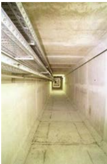
Förläggning i tunnel
