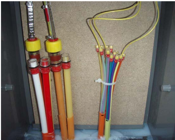
Exempel på korrekt tätning av kanalisationsrör
