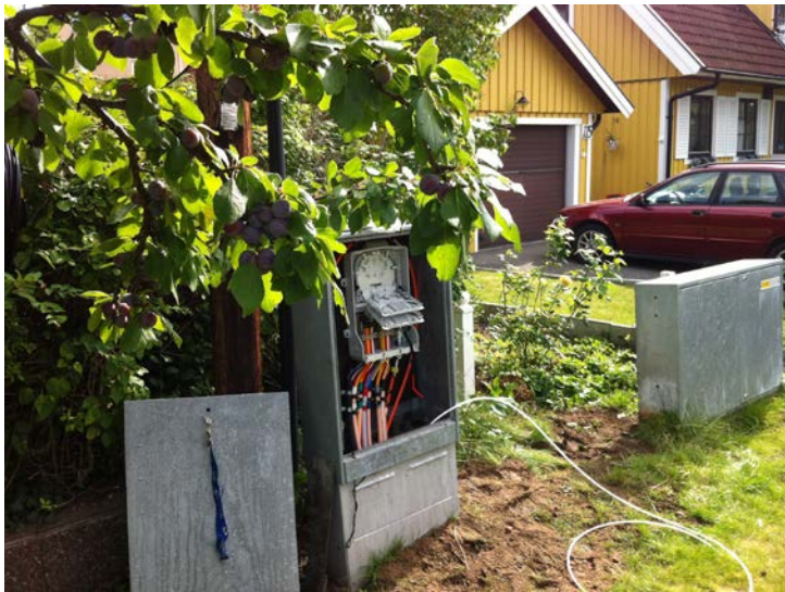
Exempel på markskåp för utomhusbruk med skarvenhet
