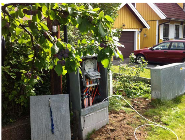
Exempel på markskåp för utomhusbruk med skarvenhet
