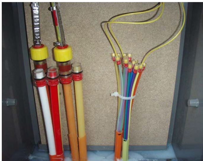
Exempel på korrekt tätning av kanalisationsrör
