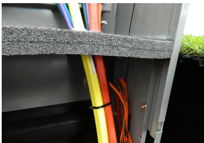
Exempel på korrekt slitsad kappa
