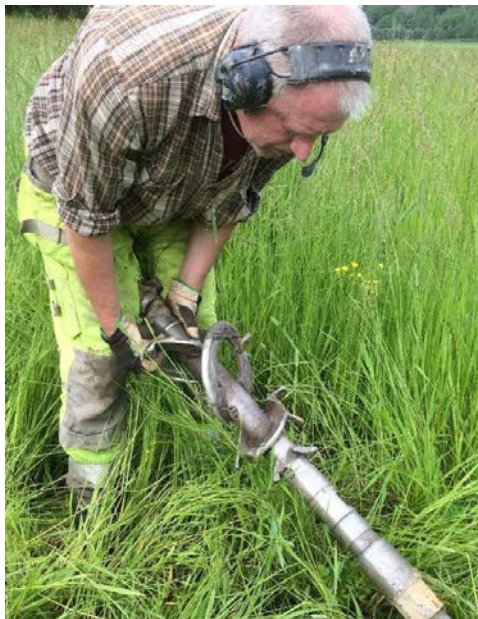
Rymmare monteras på pilotstång
