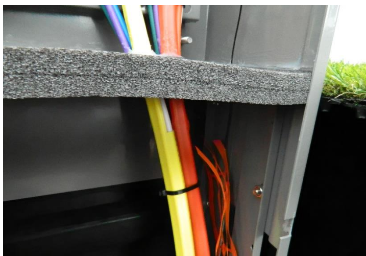
Exempel på korrekt slitsad kapp
