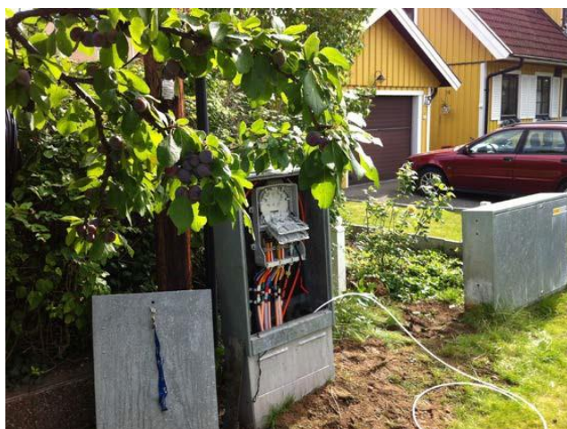
Exempel på markskåp för utomhusbruk med skarvenhet
