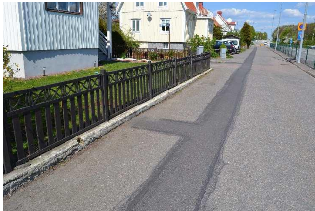
Slutresultat efter återställning vid Spårfräsning
