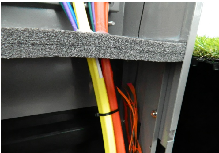
Exempel på korrekt slitsad kapp
