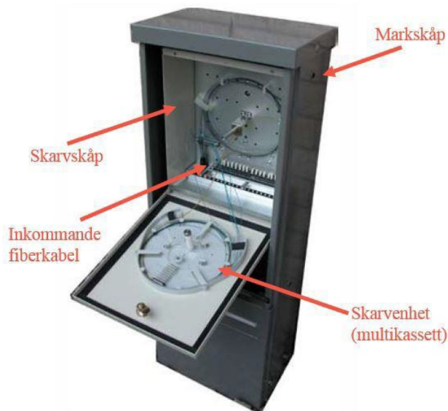
Exempel på markskåp med skarvskåp och skarvkassett.
