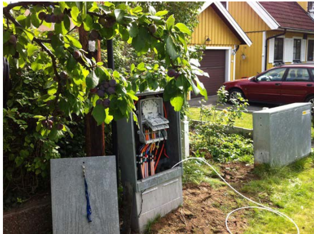
Exempel på markskåp för utomhusbruk med skarvenhet
