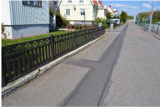
Slutresultat efter återställning vid Spårfräsning
