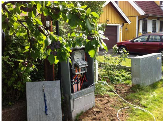
Exempel på markskåp för utomhusbruk med skarvenhet
