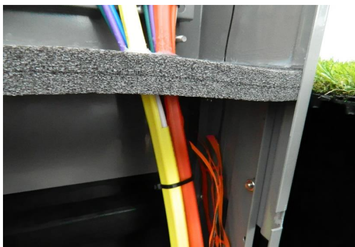
Exempel på korrekt slitsad kappa
