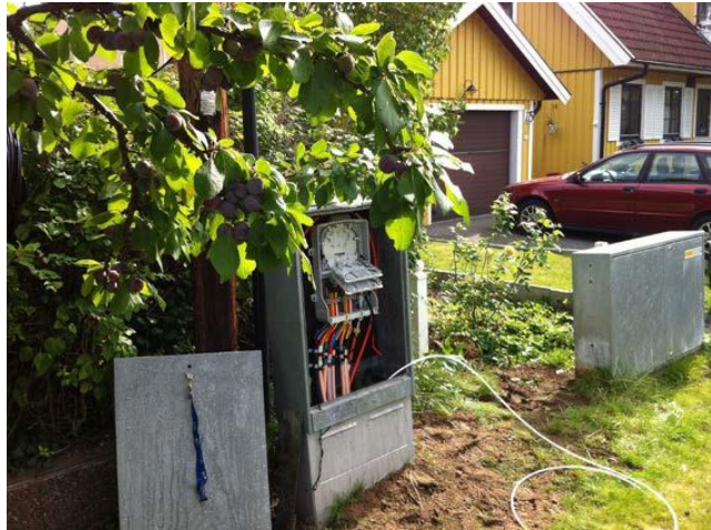
Exempel på markskåp för utomhusbruk med skarvenhet
