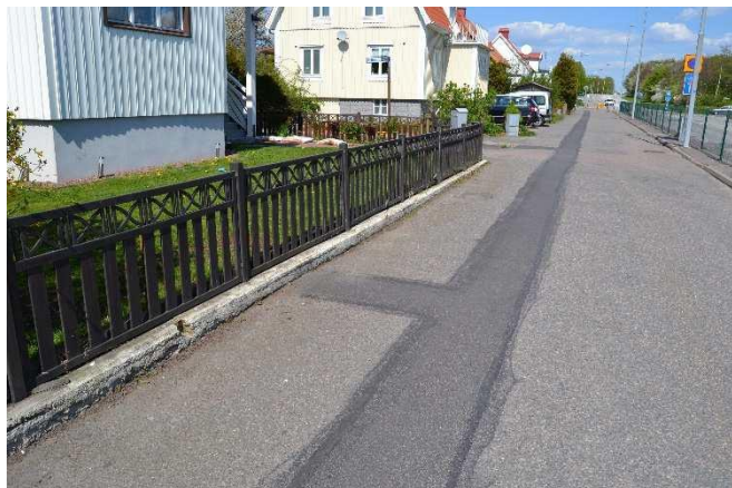
Slutresultat efter återställning vid Spårfräsning
