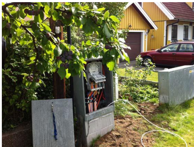
Exempel på markskåp för utomhusbruk med skarvenhet
