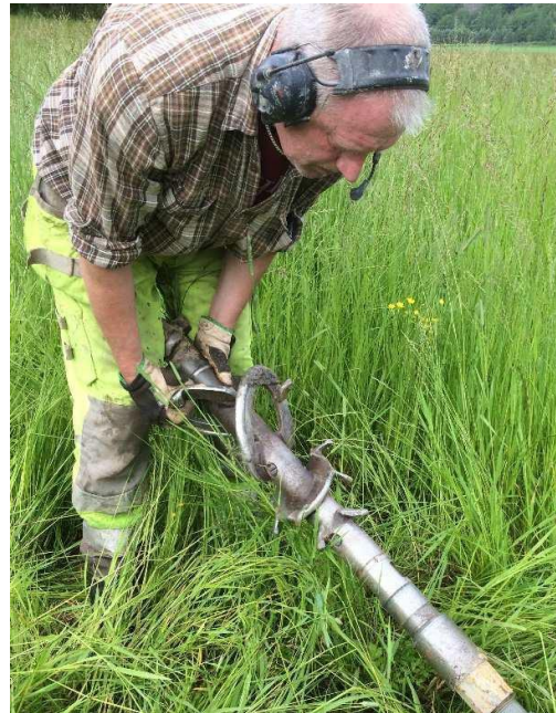
Rymmare monteras på pilotstång
