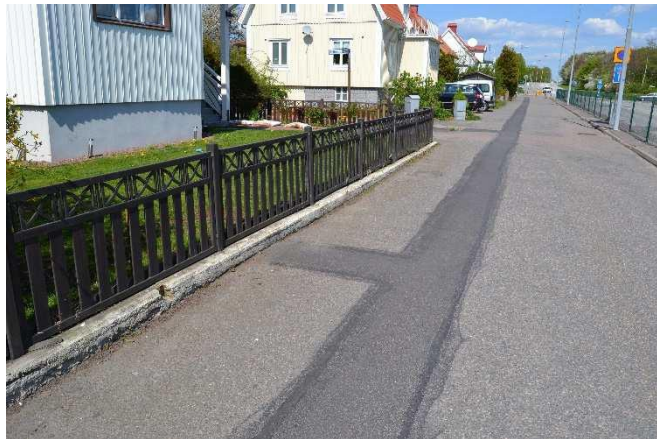
Slutresultat efter återställning vid Spårfräsning
