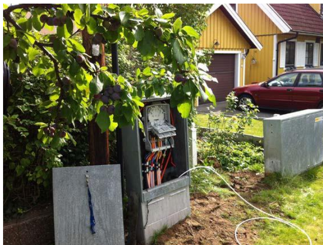
Exempel på markskåp för utomhusbruk med skarvenhet
