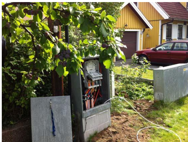
Exempel på markskåp för utomhusbruk med skarvenhet
