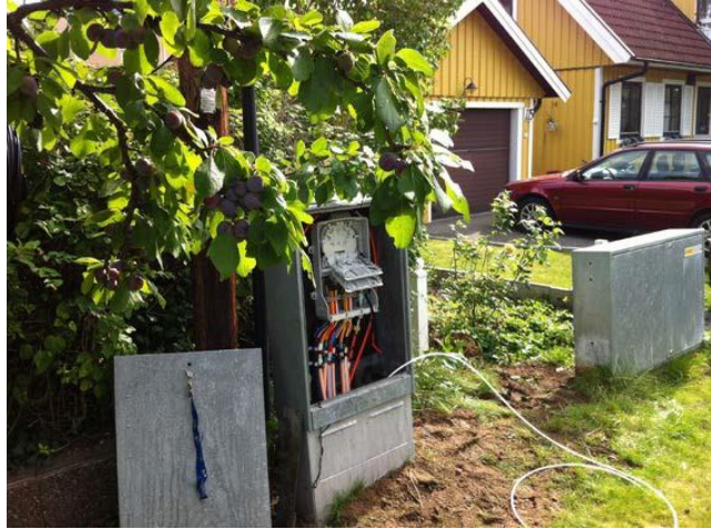
Exempel på markskåp för utomhusbruk med skarvenhet
