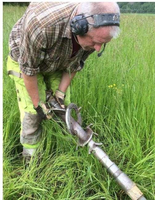
Rymmare monteras på pilotstång
