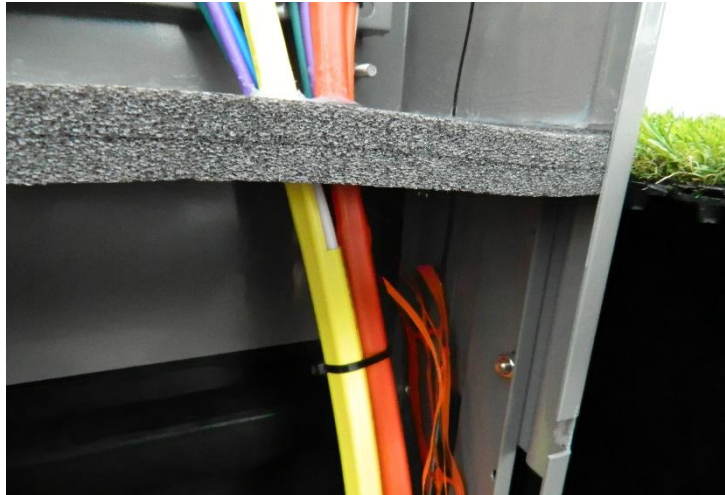
Exempel på korrekt slitsad kapp
