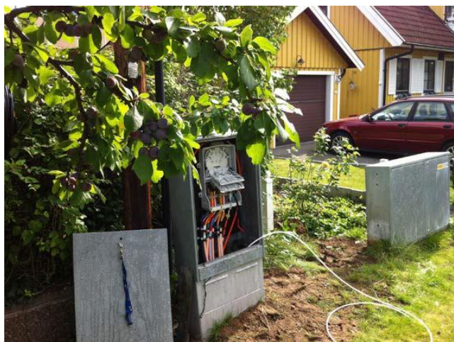
Exempel på markskåp för utomhusbruk med skarvenhet
