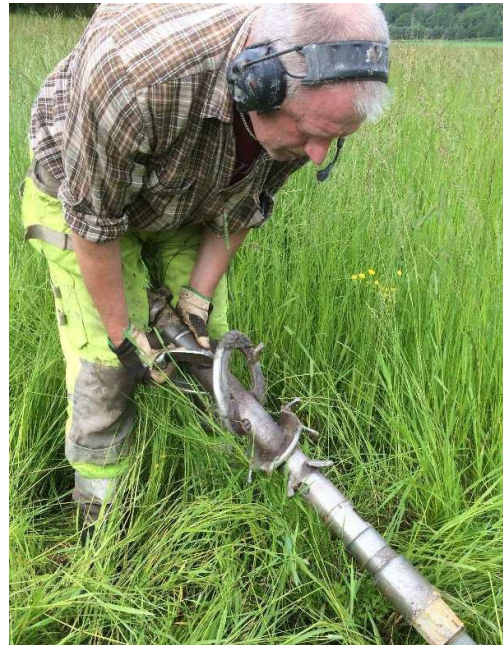
Rymmare monteras på pilotstång
