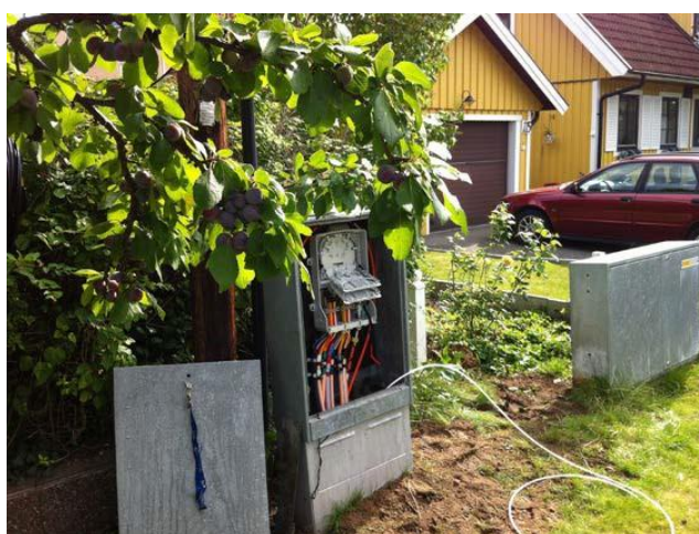
Exempel på markskåp för utomhusbruk med skarvenhet
