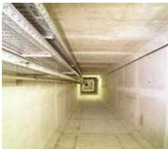
Förläggning i tunnel.
