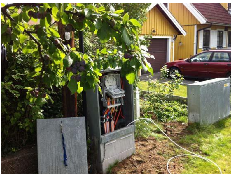
Exempel på markskåp för utomhusbruk med skarvenhet.
