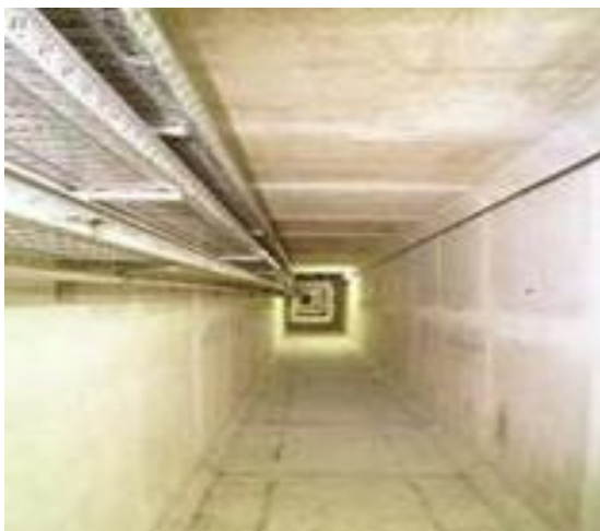
Förläggning i tunnel.
