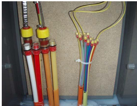
Exempel på korrekt tätning av kanalisation.
