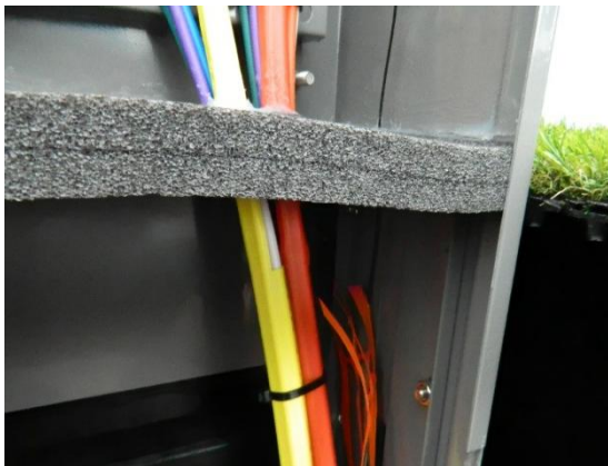
Exempel på korrekt slitsad kapp.
