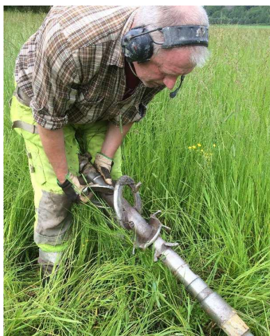
Rymmare monteras på pilotstång
